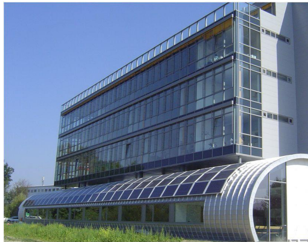
Abbildung 1: Westfassade des alki-TECHNIK-Gebäudes [Zörner2006]
